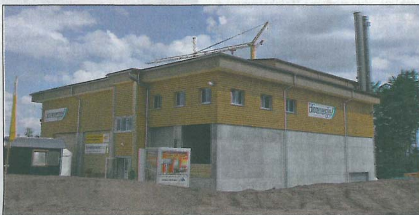
Bioenergie Pfalzgrafenweiler im Industriegebiet „Schornzhardt“
